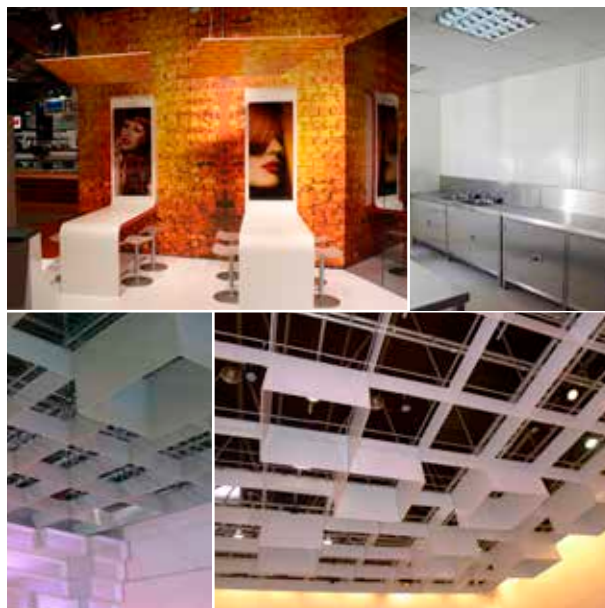
Разнообразные подвесные потолочные конструкции из KAPA®tech.
